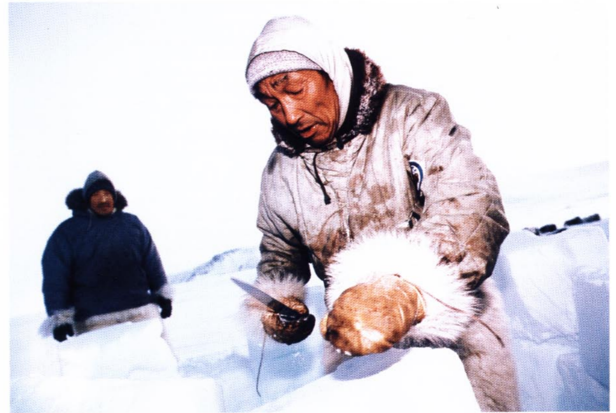
Auf Messers Schneide: Inuits beim Iglu-Bau – die Schneeböcke werden auf die passende Größe zugeschnitten
